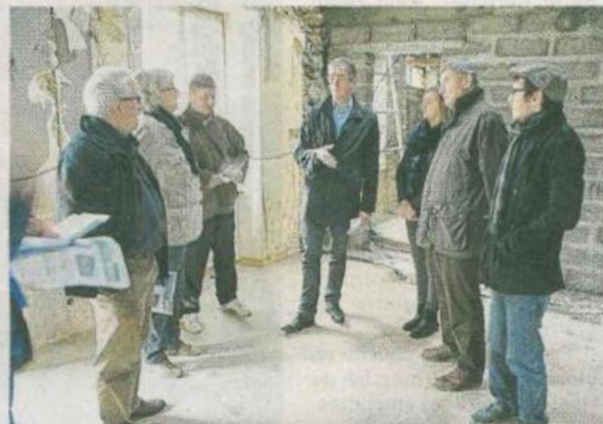
Visite des travaux chez Mélanie et Sébastien Fierville à Saint-Paul-du-Vernay par le CDHAT et l'intercom.
